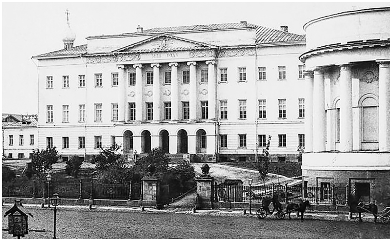
Здание Московского университета на Моховой. Фото 1870 г.
